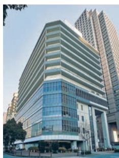
病院建物の写真
