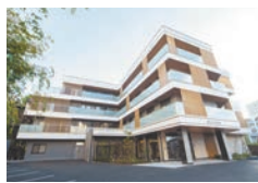
上質でありながらアットホームな雰囲気。ホテル事業で培ったノウハウを生かしています 土地・建物／賃借
